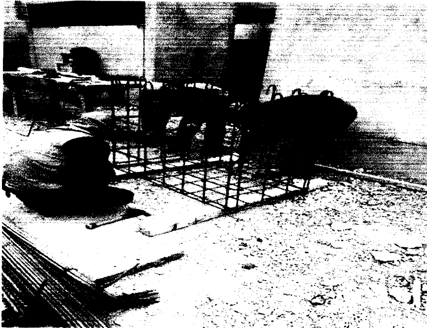
Figura 3: Acero de refuerzo para muro en Trampa de grasa.
